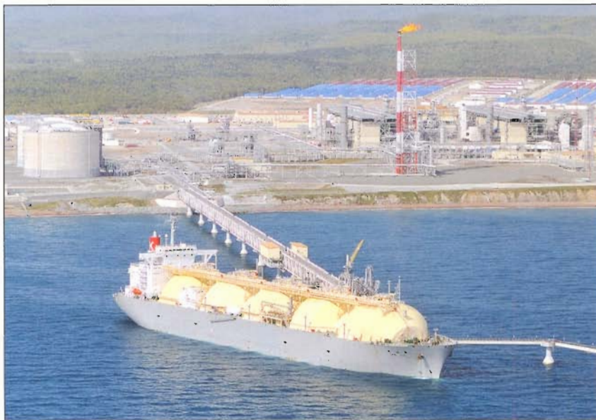
Фото 5. Завод по производству сжиженного природного газа с терминалом отгрузки нефти
